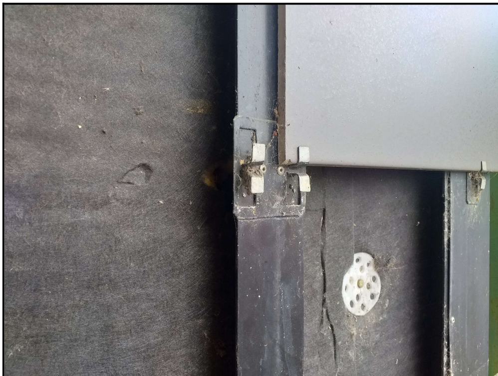
Fot. 7.9. Sposób mocowania aktualnych płyt elewacyjnych do podkonstrukcji
