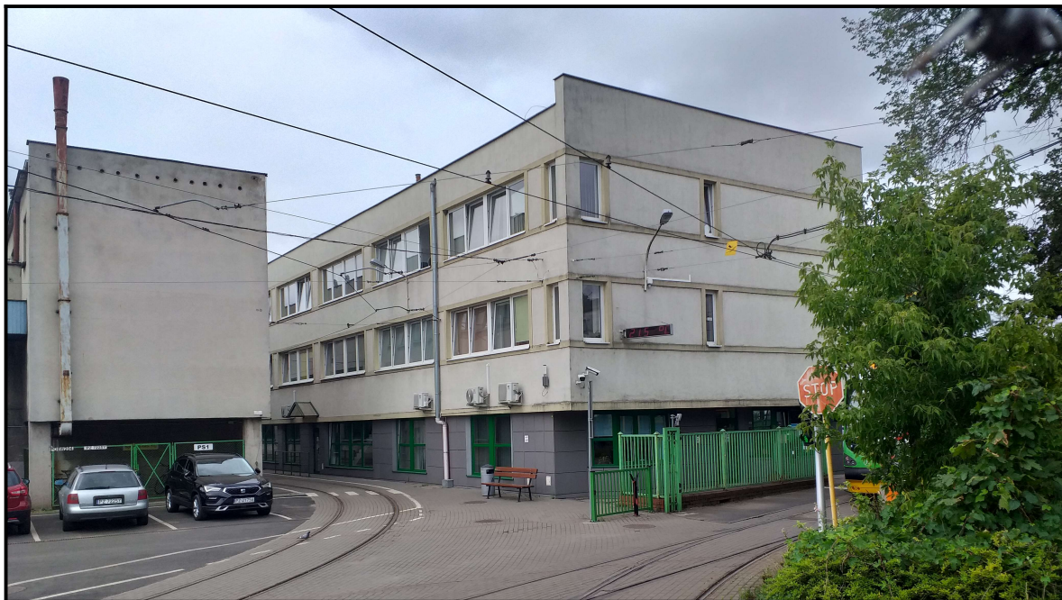
Fot. 7.3. Elewacja budynku od strony zajezdni tramwajowej
