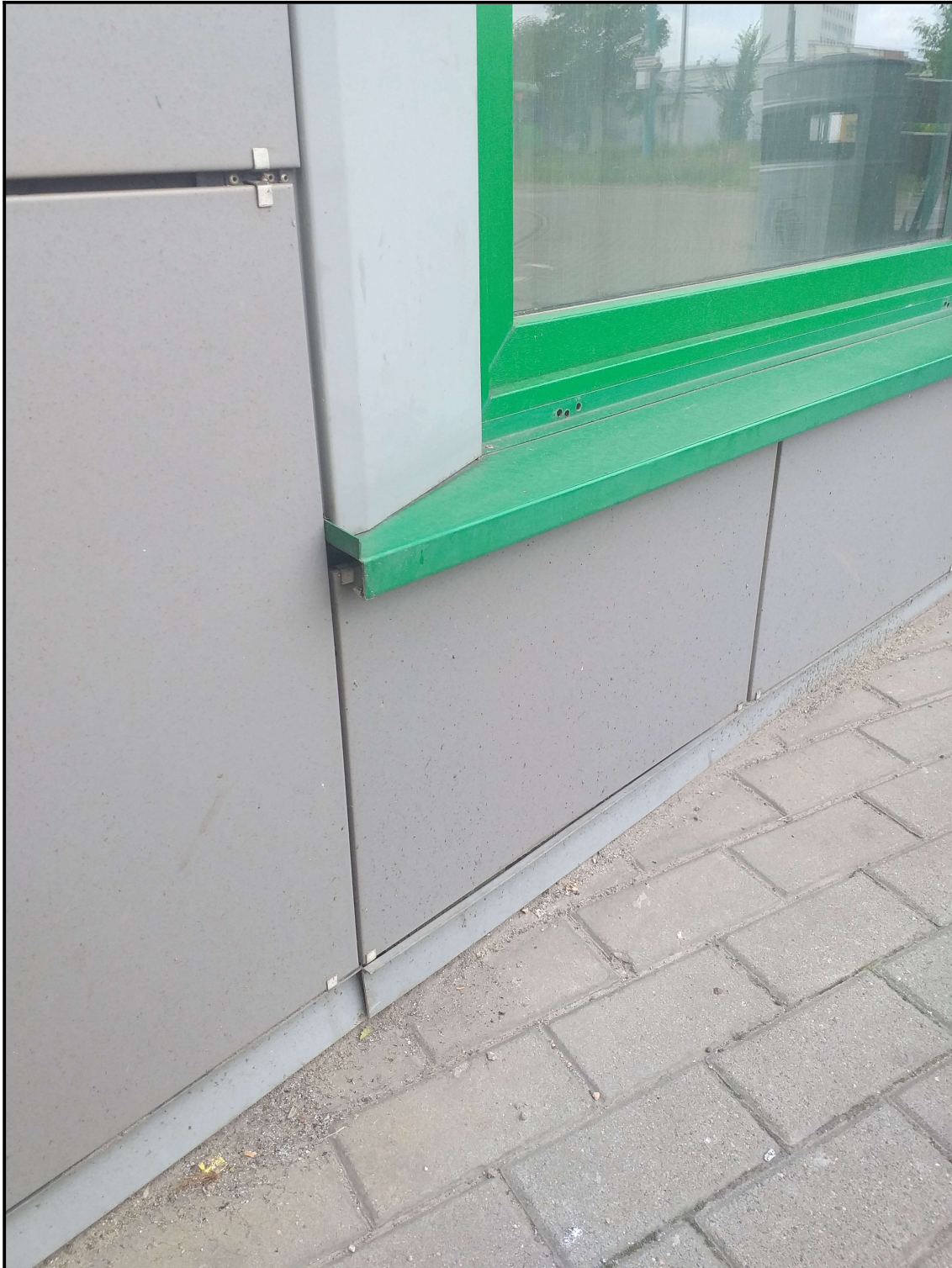
Fot. 7.8. Obróbki blacharskie
