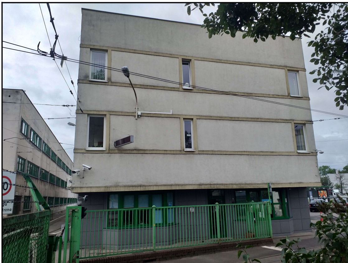
Fot. 7.2 Elewacja budynku od strony ulicy Fortecznej
