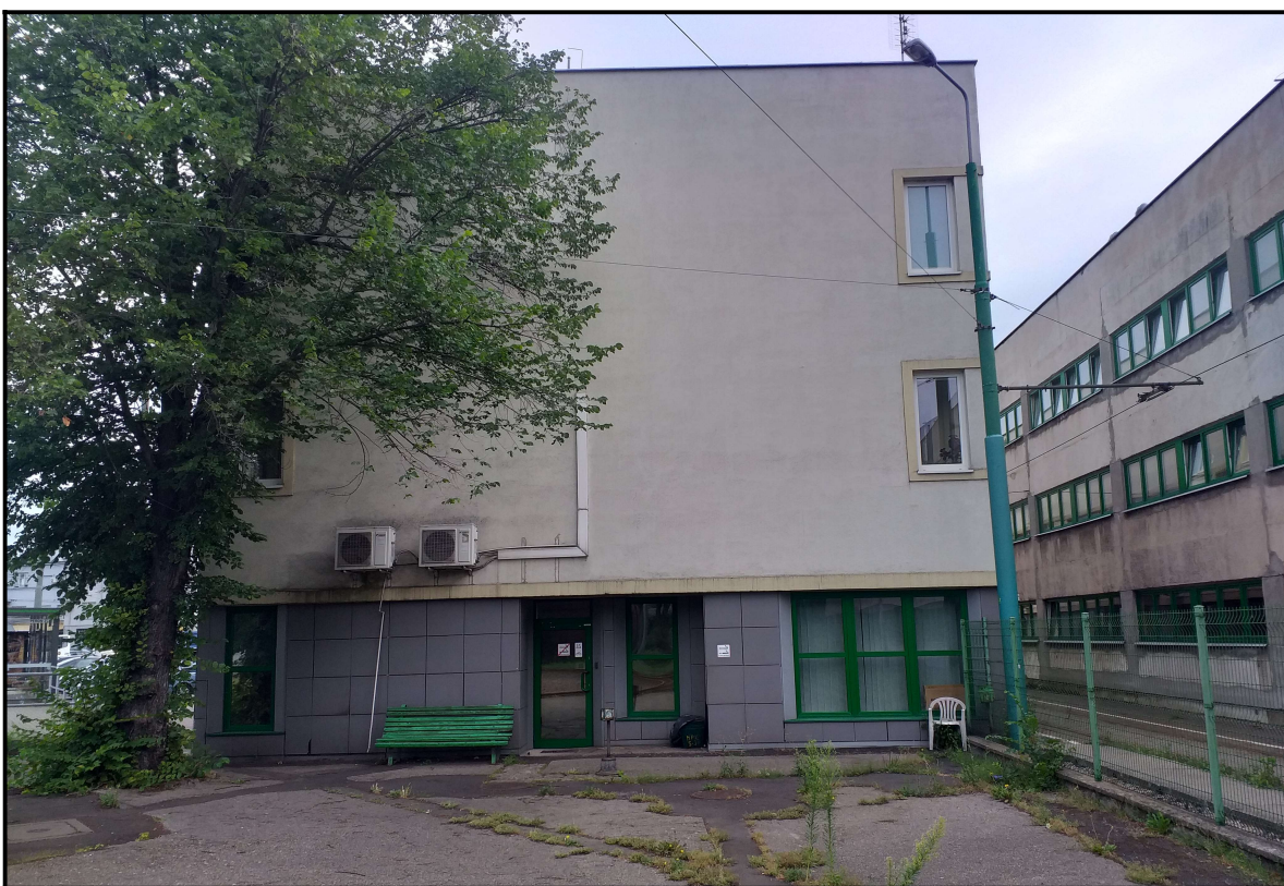
Fot. 7.4. Elewacja budynku od strony pętli tramwajowej
