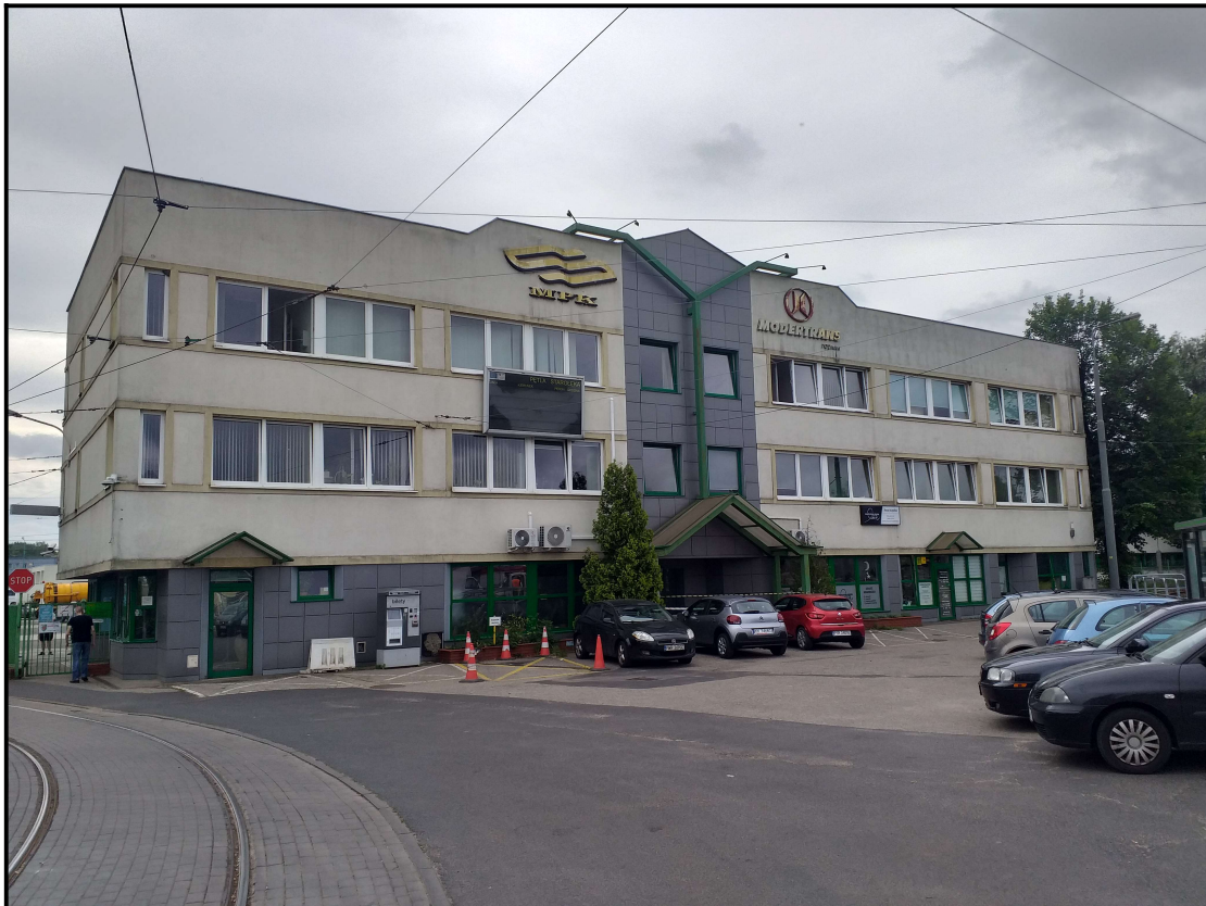
Fot. 7.1. Elewacja budynku od strony ulicy Starołęckiej
