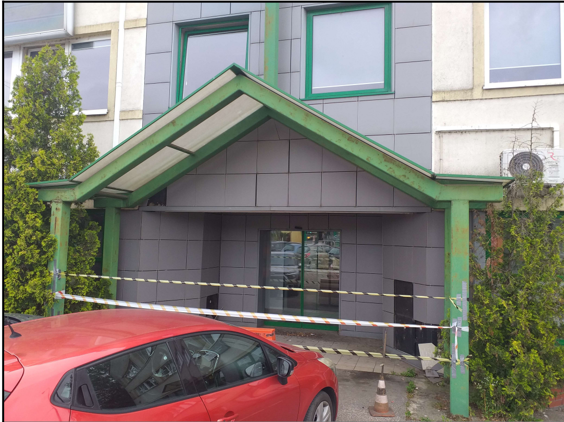
Fot. 7.6. Stalowa konstrukcja zadaszona nad nieużytkowanym wejściem głównym do budynku
