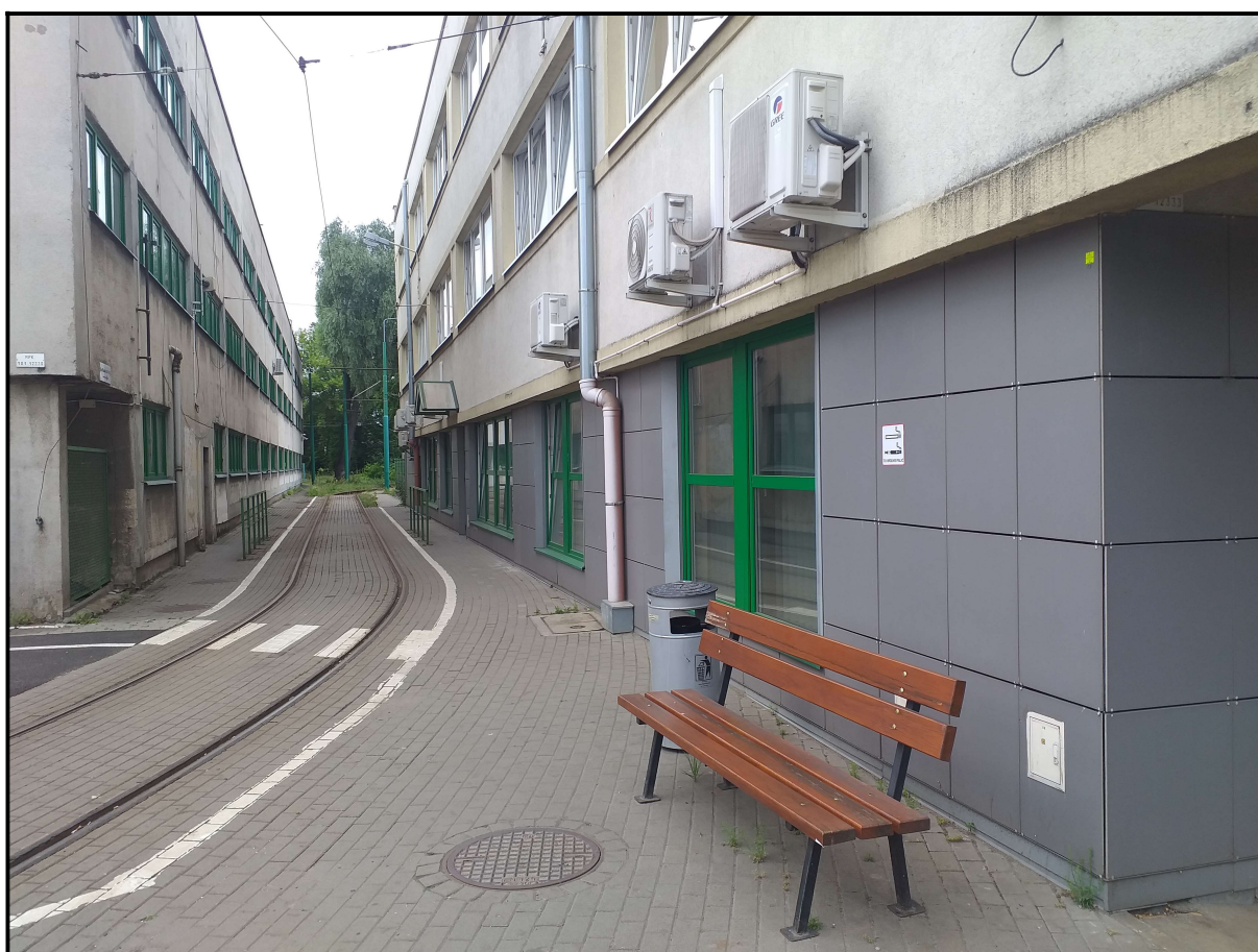
Fot. 7.11. Tory przebiegające w bezpośrednim sąsiedztwie budynku od strony zajezdni
