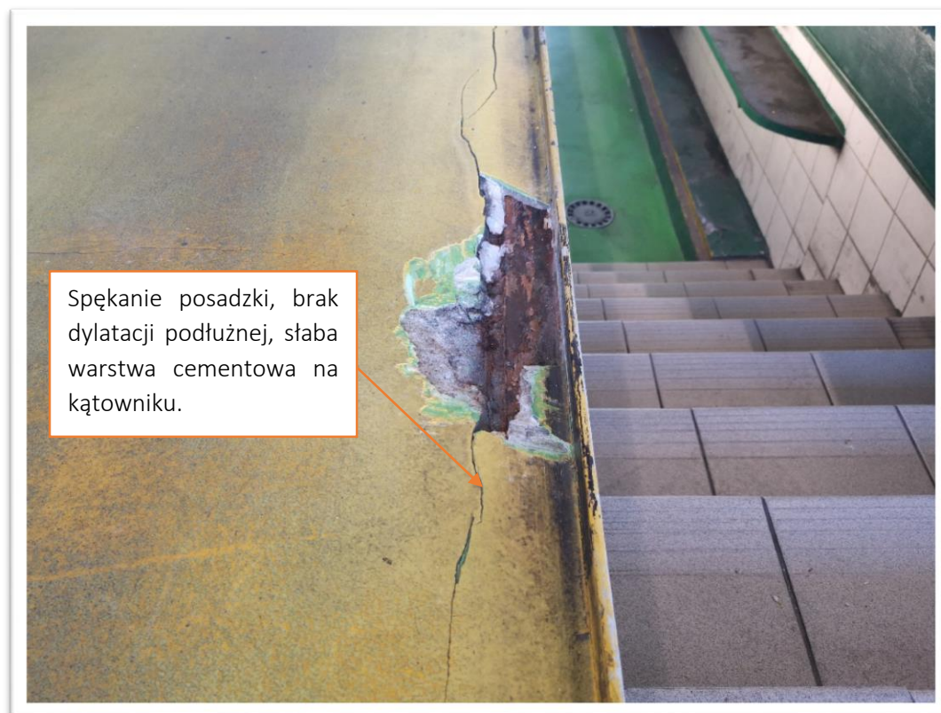
Zdjęcie 3 - Słaba warstwa posadzki na kątowniku, wymaga zdylatowania.
